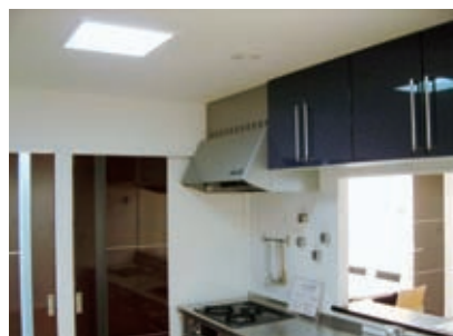
▲ミラーコートKを使用した光ダクト (照明なしでも明るいキッチン)
