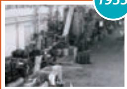
No.1電気錫めっきライン
