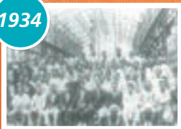
下松工場最初の棟上げ
