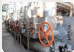
バルブ自動開閉器(ベストルク)
