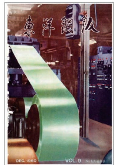
ビニトップ（塩ビ鋼板）製造設備
