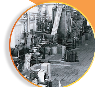
電気錫めっきライン
